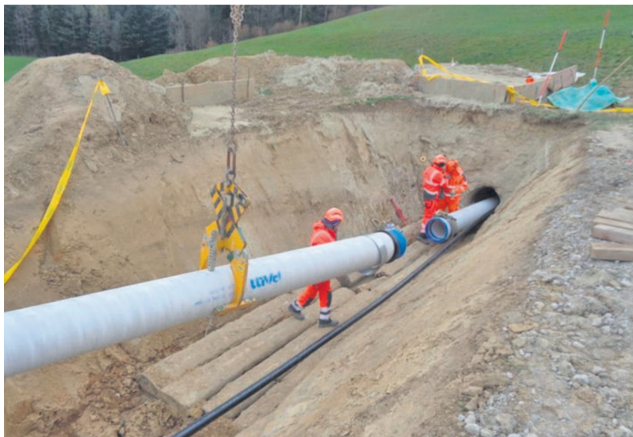
Die neue Leitung wurde auf einer Länge von 5,2 Kilometern verlegt. FOTO ZVG
